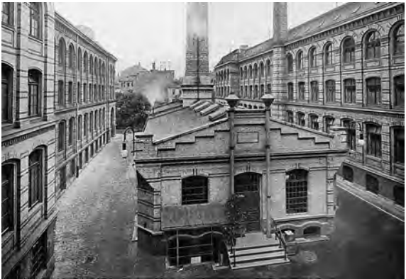
Innenhof mit Maschinenhaus
